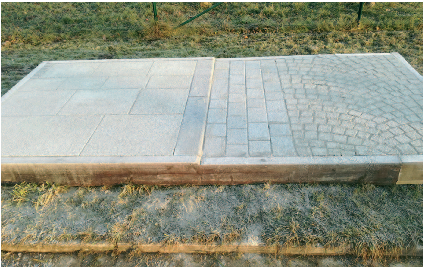
Musterfläche kann am Bauhof besichtigt werden. Die großen Platten mit 60 cm Breite (links im Bild unterste Reihe) werden nicht verwendet.
