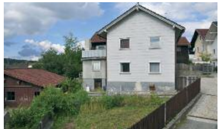
Das bestehende Wohnhaus wird abgebrochen
