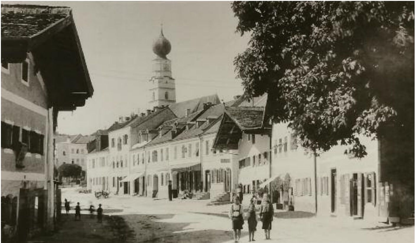
Das uralte Hutmacher-Holzhaus Vetter hatte wegen seiner enormen Baufähigkeit die „Daseinsberechtigung“ verloren und ist 1931 durch Abbruch von der Bildfläche verschwunden (heute Michael Wagner).
