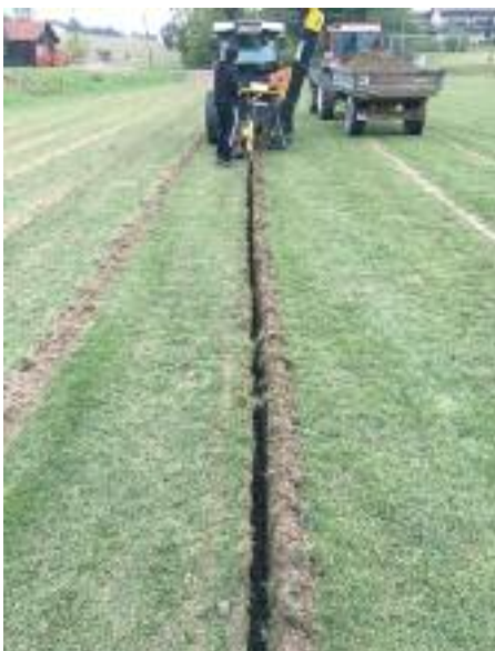
Die Sanierung des Trainingsplatzes. Foto: Fabian Schrädobler
