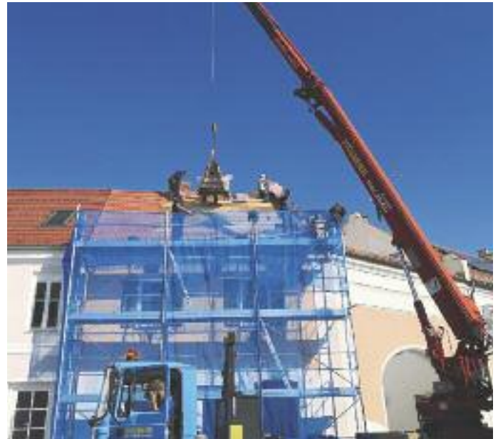
Bei herrlichem Herbstwetter konnten die Arbeiten am Dach ohne Probleme erledigt werden.
