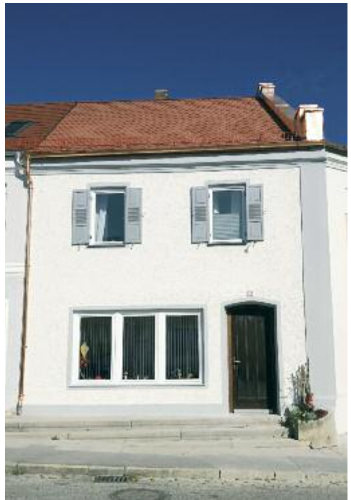
Nach den abgeschlossenen Sanierungsarbeiten kann man auf unserem Marktplatz wieder ein weiteres saniertes Gebäude sehen.
